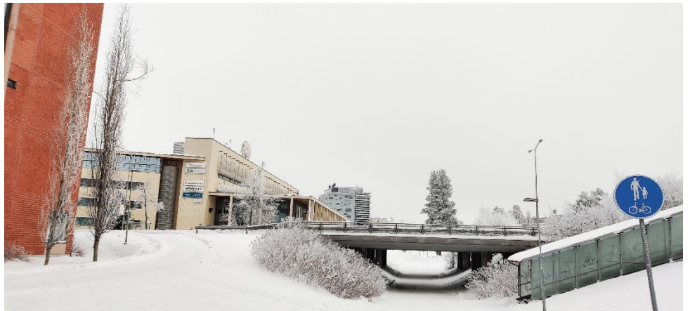
Kuva 25: Valokuva Ahvenniitynraitin alikulkukäytävästä, kuvattu tammikuussa 2021.
